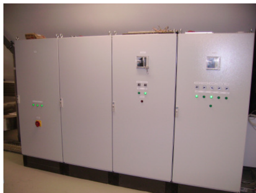
Master- und Unterstationen einer Liegenschaft
